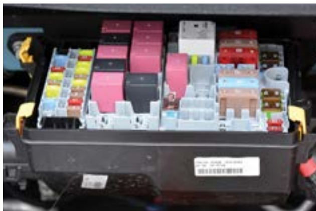
Bezpieczniki w komorze silnika – wysoko i blisko ściany grodziowej
