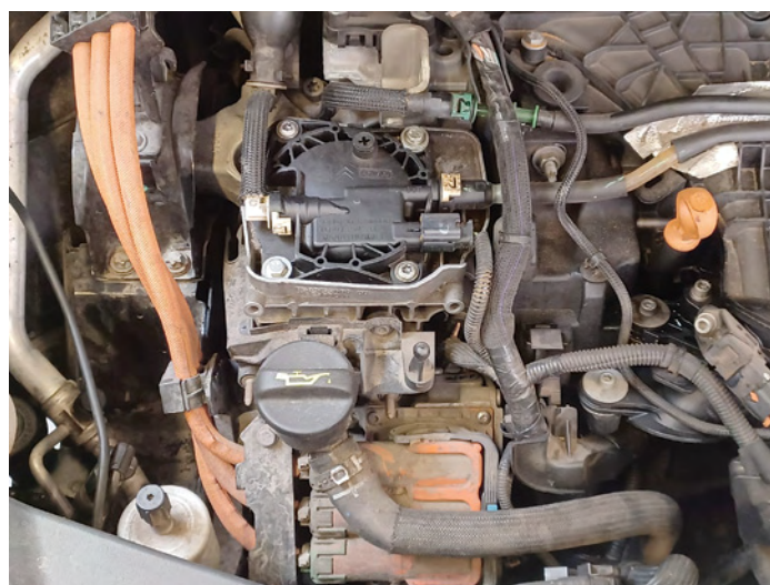
Trójfazowe złącze wysokiego napięcia HV alternatora odwracalnego w komorze silnika 2,0 HDI. Alternator odwracalny może pracować jako rozrusznik lub jako generator (alternator), ładując akumulator trakcyjny, który z kolei przez przetwornicę DC-DC zasila instalację 12 V. Przesył energii elektrycznej do tylnego zespołu hybrydowego był oparty na ułożonej pod podłogą trójfazowej instalacji prądu przemiennego z trzema przewodami HV
