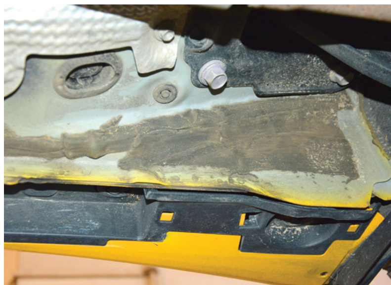
To ma chronić przed korozją. Środka mało, do tego położony niezbyt starannie
